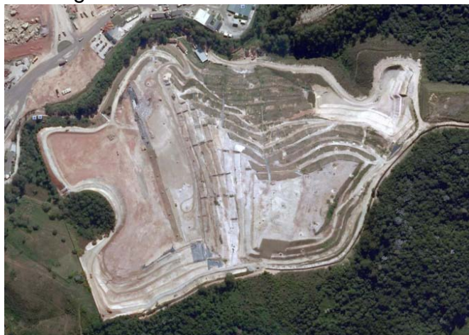
Figura 21 - Aterro Sanitário Quitaúna
