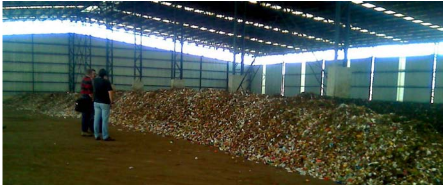
Figura 19 - Unidade de Tratamento de Resíduos Orgânicos
