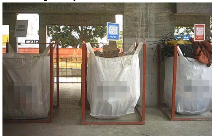
Figura 25 – Organização de resíduos em canteiro de obras
