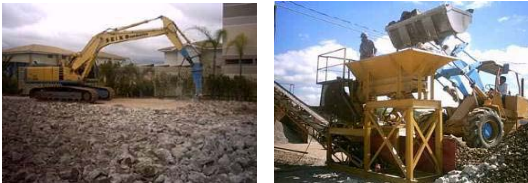
Figura 33 – Desmonte e reciclagem de concreto (12.000 m 3 ) em GRU
